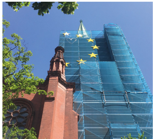
Baugerüst am Turm der Gethsemanekirche in Berlin. Foto: Johan Wagner
