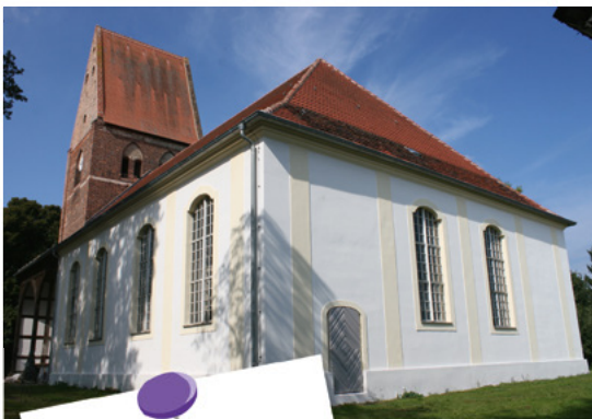
Kirchenschiff im sanierten Zustand. F.: Andreas Flender
