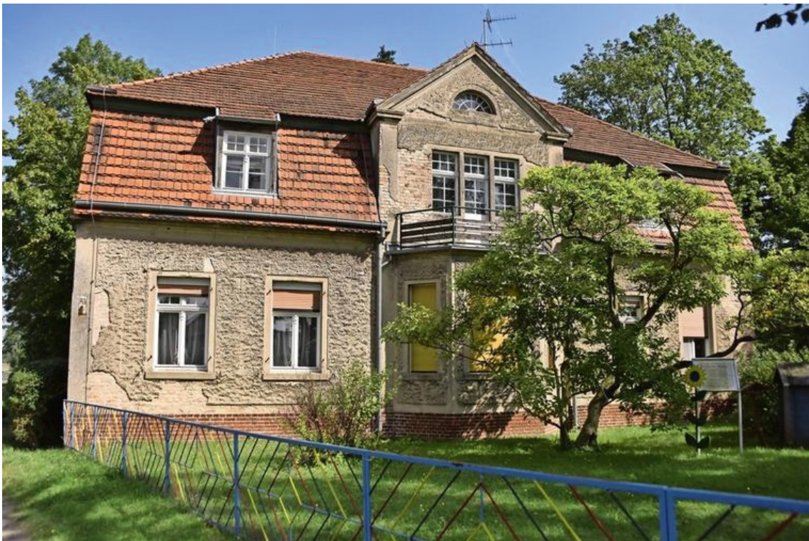
Das ehemalige Pfarrhaus in Radensleben soll zum Demonstrationsobjekt für energieeffiziente Bestandssanierung werden. Foto: Gesamtkirchengemeinde Protzen-Wustrau-Radensleben
