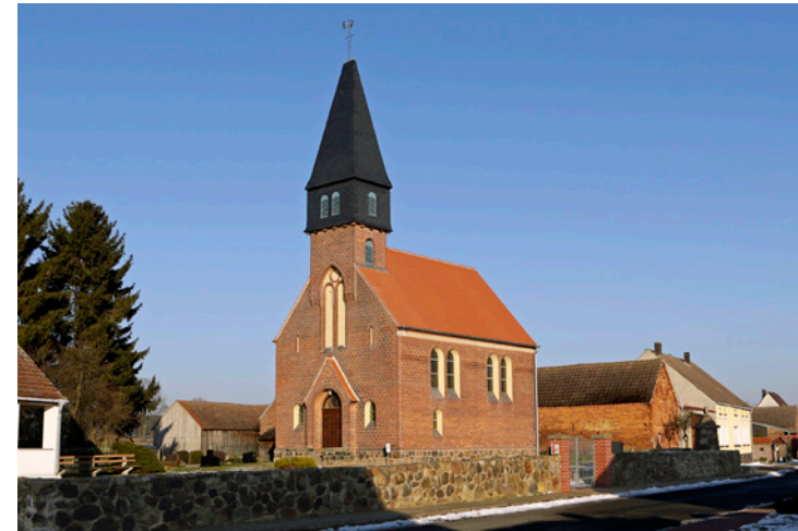
Kirche Lühnsdorf im Ensemble nach durchgeführten Maßnahmen © Manfred Kahl
