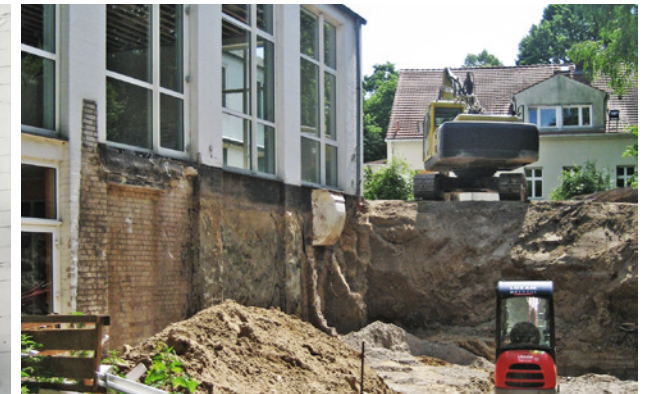
Die Baustelle im Juli 2017
